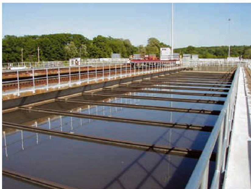
Osadnik o szerokości 36 stóp — łańcuch SAV709 ze zgarniaczami HMAX Extreme Duty
